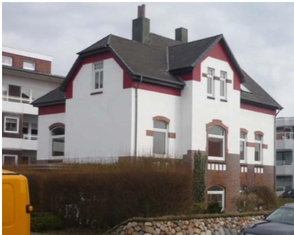
Die Villa Ronny vor der Sanierung
